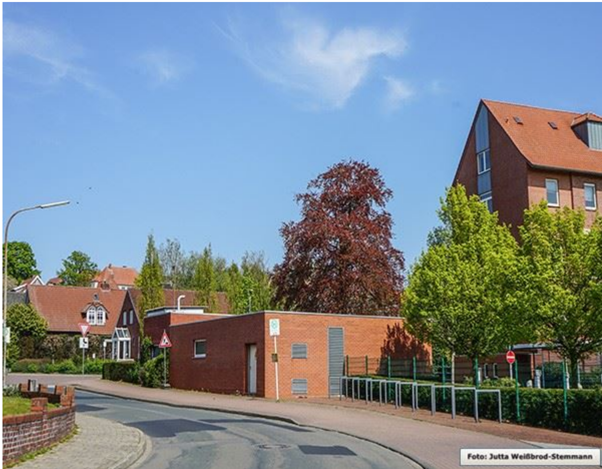
Leberichstiege, April 2020, Blick nach Nordosten.
